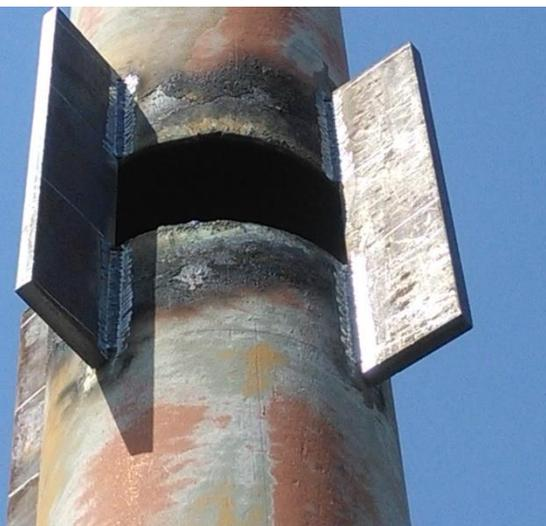
Esempio di piastre saldate su colonna cilindrica
